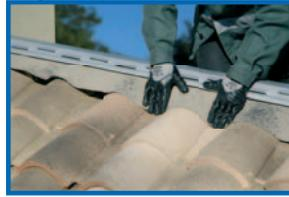
Maroufler la bavette du sommet du galbe de la tuile (couvert) vers le creux des tuiles (courant). Bien presser les bavettes contre les tuiles.
