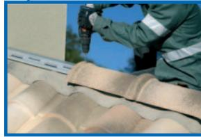
A l'extrémité du faîtage ou de l'arêtier, couper le closoir LAHE-PRO avec une cisaille ou une meuleuse. La chute peut être réutilisée lors d'un prochain chantier.
