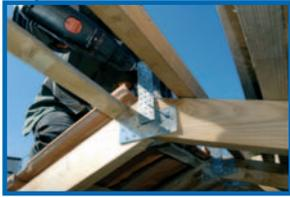
Positionner et fixer l'étrier support de lisse sur la charpente à 5 cm environ au-dessus du dernier rang de tuiles.
