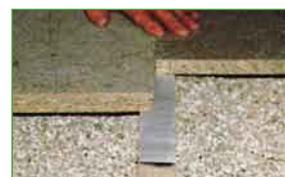
Interposer des bandes résilientes sur les solives avant la pose d'un panneau de particules, dans le cas d'exigences acoustiques
