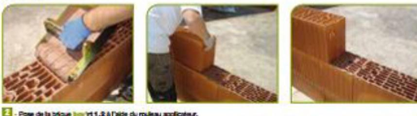
2 - Pose de la brique bvg<sup>rt</sup>1.2 à l'aide du rouleau applicateur.
