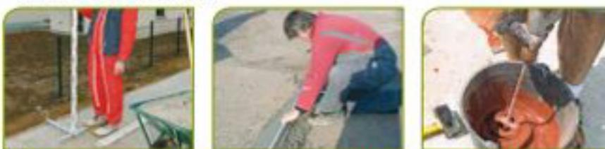
1 - Réalisation du premier rang au mortier traditionnel hydrocal (sp. 2 à 4 cm), à l'aide de plateau. Attention, le premier rang doit être d'une épaisseur parfaite.
