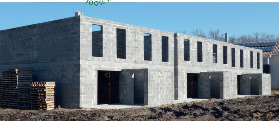
Bloc béton isolant fabriqué à partir d'ardoise expansée bénéficiant de performances mécaniques et thermiques parmi les meilleures du marché.
