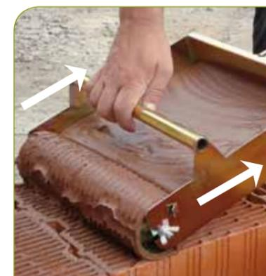
**Le Joint horizontal est constitué de mortier Joint Mince.**
