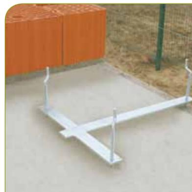
**2** - A l'aide d'un niveau laser et des platines, réaliser le niveau du premier joint de mortier au point haut de la dalle.
